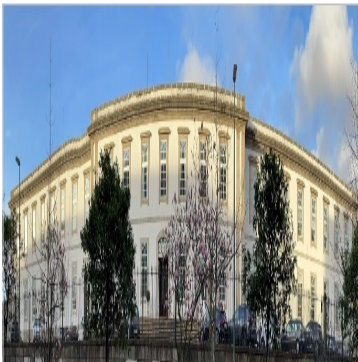
Figura 8 - Hospital Forças Armadas Polo Porto, na atualidade.
