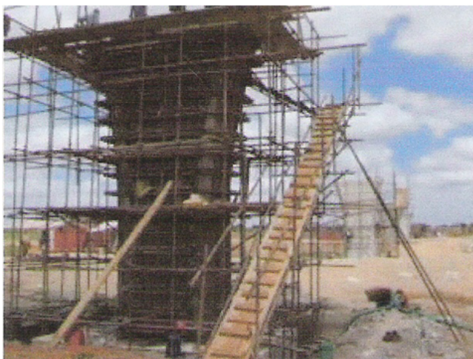
Fig. 58 – As obras da citada ponte estão em bom andamento
