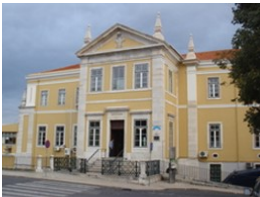
Figura 2 - Hospital da Marinha - Santa Clara (vista actual)
