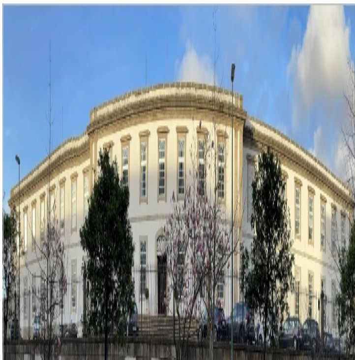
Figura 8 - Hospital Forças Armadas Polo Porto, na atualidade.
