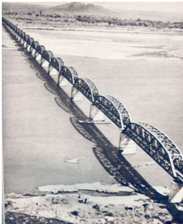
Fig.29 – Ponte de Mutarara sobre o Zambeze
