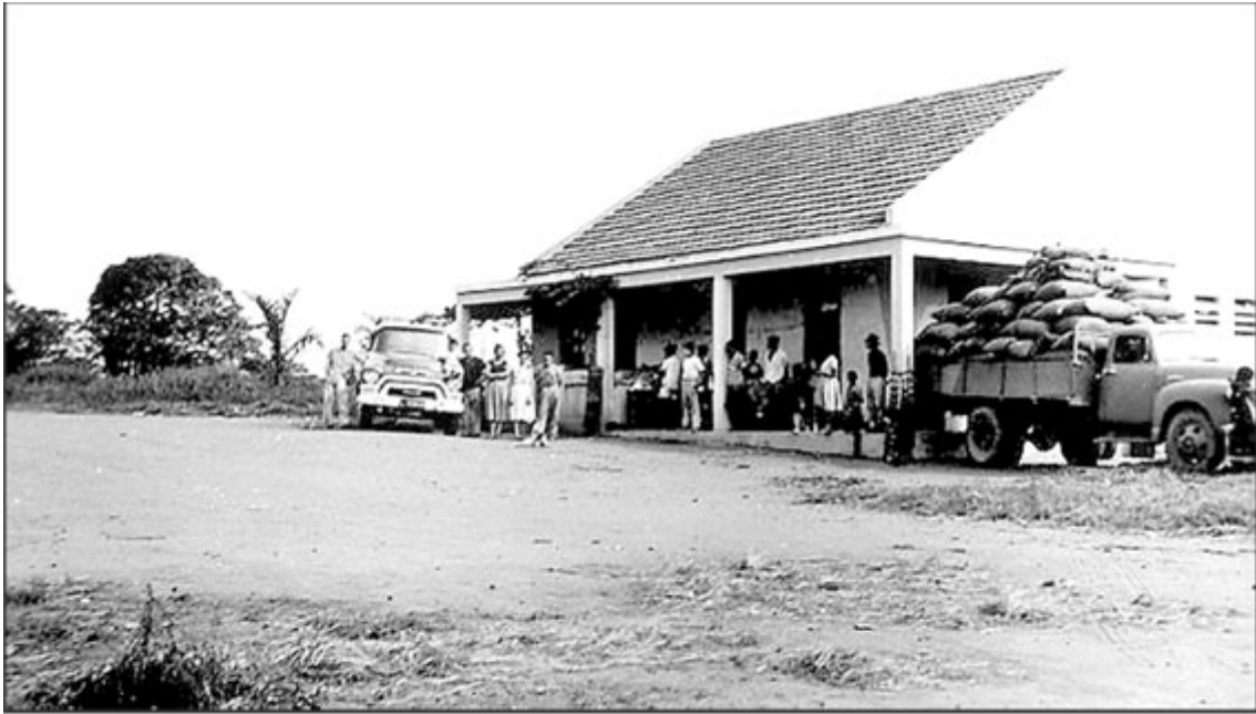
Loja comercial, com residência anexa (povoação comercial de Lemboa, 1956)
