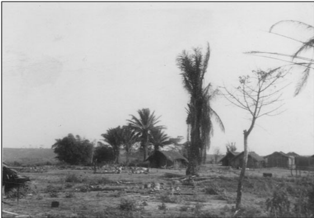
A vata Diumba, distante um quilómetro da povoação de Kibokolo, a razia é quase total e isso deve-se especialmente ao tipo de material usado para a construção das habitações
