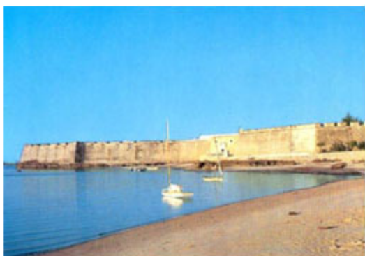
Figura 20 – Vista da Fortaleza de S. Sebastião (fachada Oeste)
