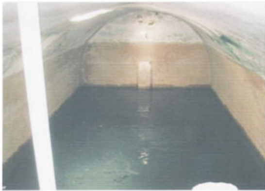
Figura 21 – Uma cisterna da fortaleza
