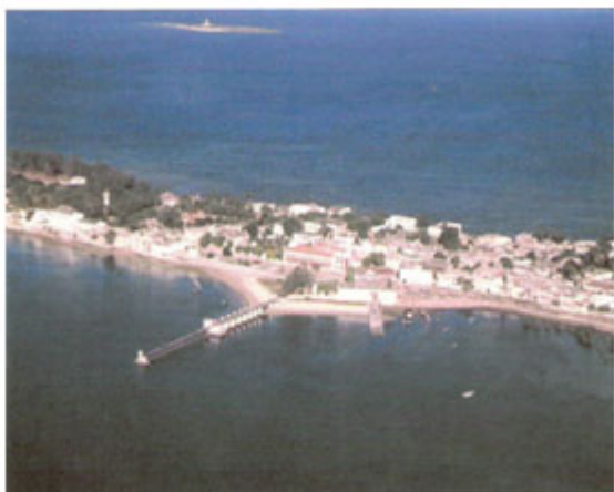
Figura 17 – Vista parcial da Ilha de Moçambique com a ponte da Alfândega (foto antiga)
