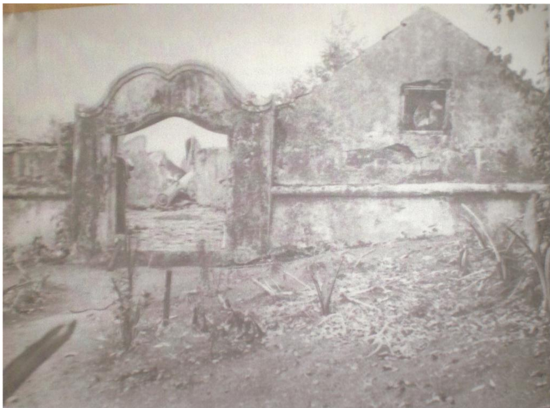
Fig. 19 - Porta de Armas (ruínas) da Fortaleza da Ponta da Mina.
