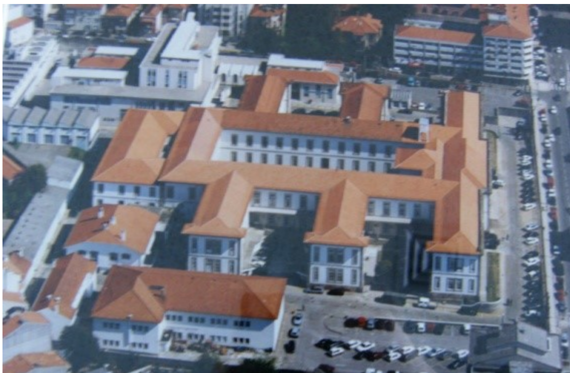
Figura 7 - Hospital Militar Regional nº1
