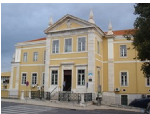
Figura 2 - Hospital da Marinha - Santa Clara (vista actual)
