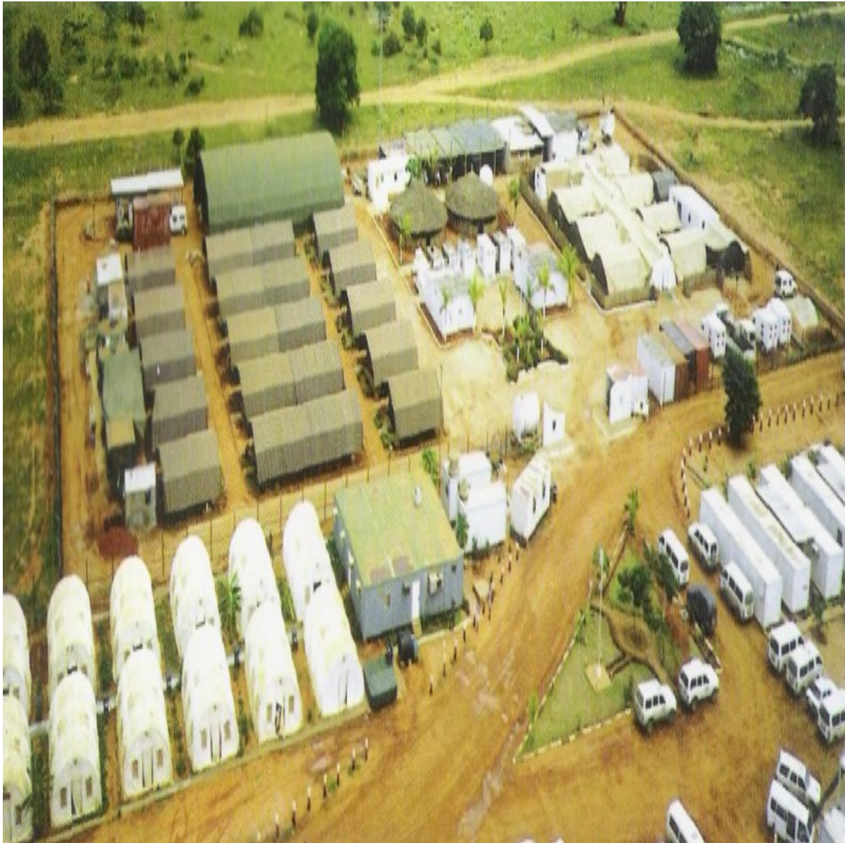
Figura 31 - MONUA - Hospital Cirúrgico Móvel
